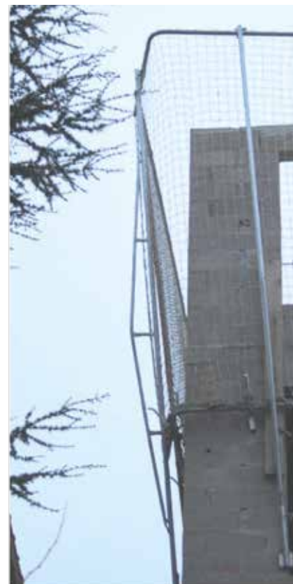
Chantier SABP à Bondy
