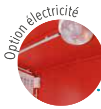
Cable électrique de branchement extérieur
