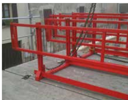
Elingage du garde-corps pour enlèvement
