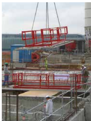
Mise en place sur chantier par jeu de 2
