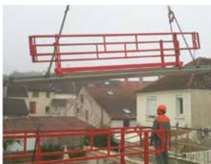
Pose par jeu de 2 sur le chantier
